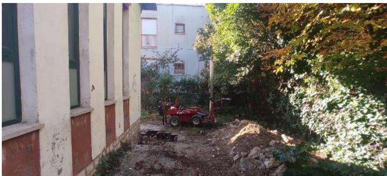
Foto 2. Esecuzione prova penetrometrica dinamica continua P2.
