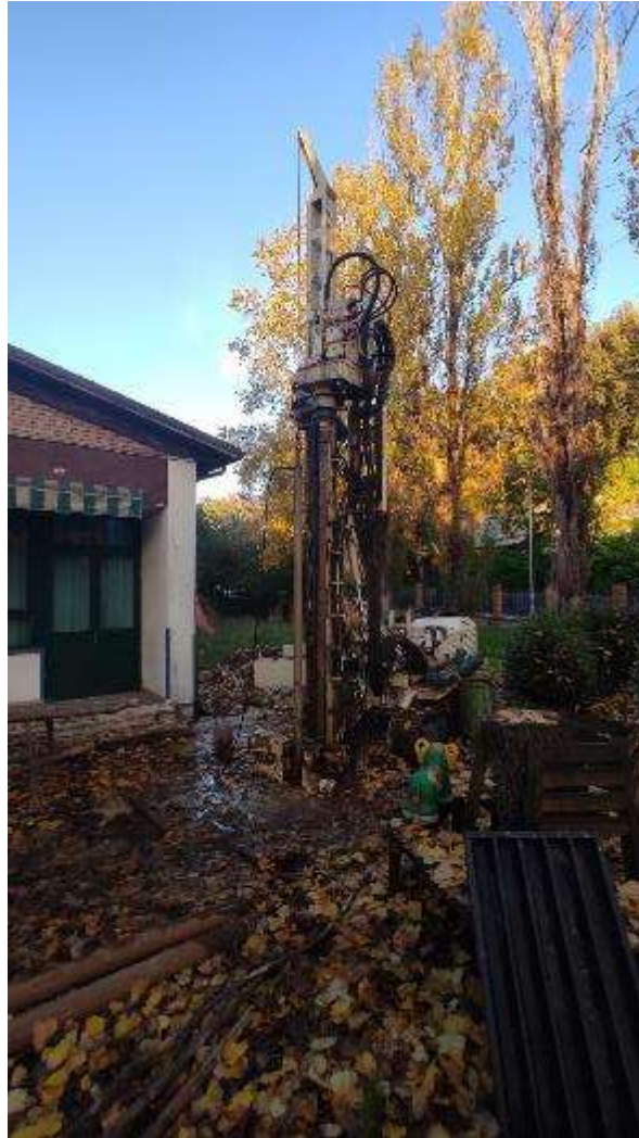
Foto esecuzione Sondaggio geognostico S1.
