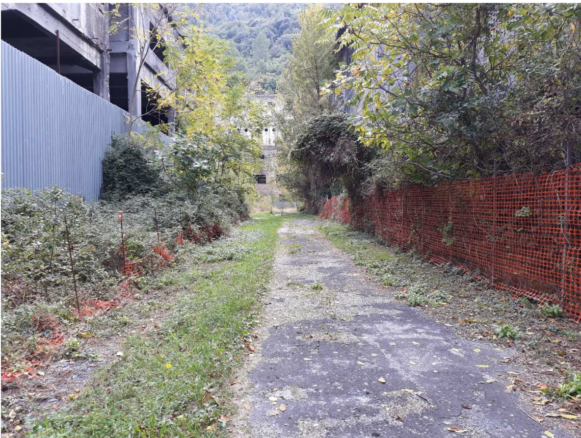
Sito di Interesse Nazionale Terni – Papigno D.M.. 468/01 – Via Carlo Neri, 18 Loc. Papigno (TR) – Edificio “F”.
