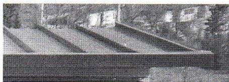
La copertura, che copre per intero la struttura è composta da pannelli termici di cm. 4 di spessore e mt. 4.50 di lunghezza, ed è tale da permettere di ricavare una tettoia di cm. 40 nella parte d'ingresso e cm 10 nella parte posteriore dei box. Nelle parti laterali la sporgenza è di cm 25. In tutte le parti dove è visibile il poliuretano interno ai pannelli di copertura sarà applicata una protezione di colore rosso siena in lamiera preverniciata.
