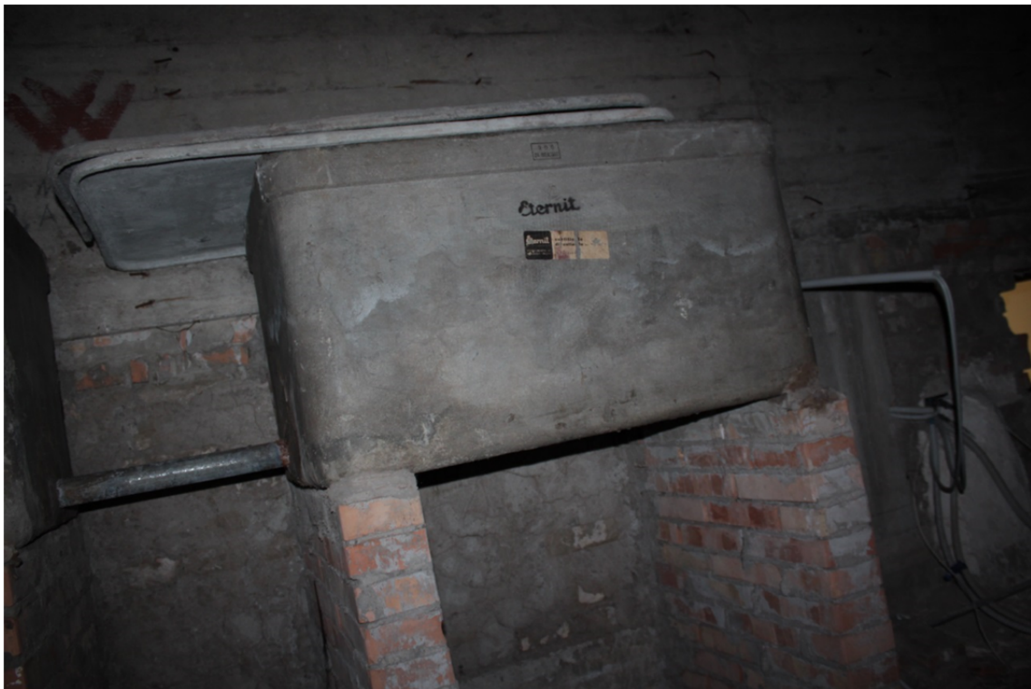
Sottotetto Edificio C - Vasi di espansione in eternit (sottotetto al di sopra del locale 108, accessibile dal locale 121)
